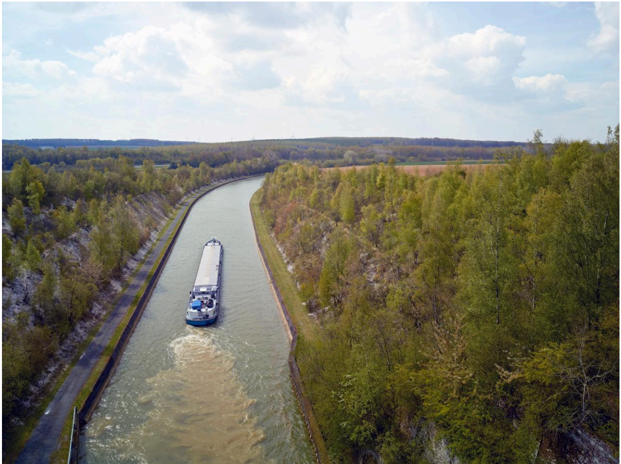
Vue depuis le pont routier sud. Péniche en transit.
