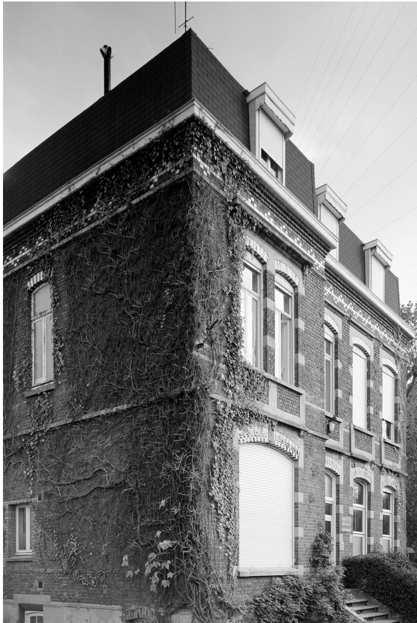
Logement patronal, élévation antérieure.
