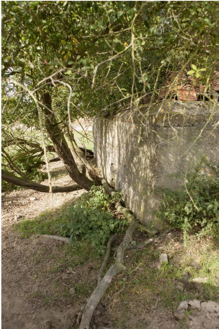
Elévation sud, vers le nord-ouest
