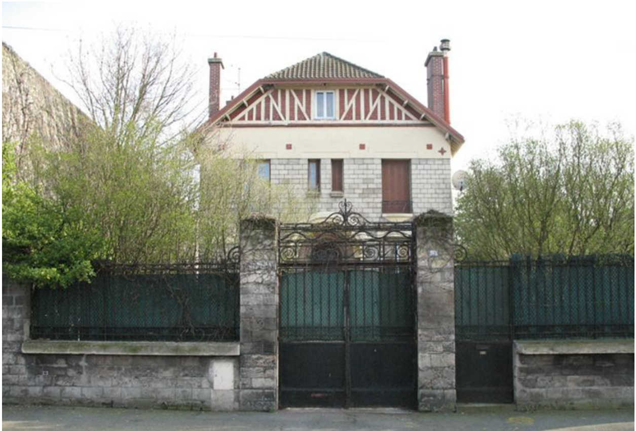
Ancienne maison du directeur rue Jean-Jaurès.
