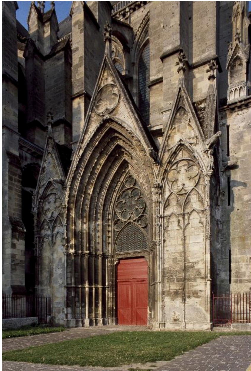
Vue de la porte du bras nord du transept.
