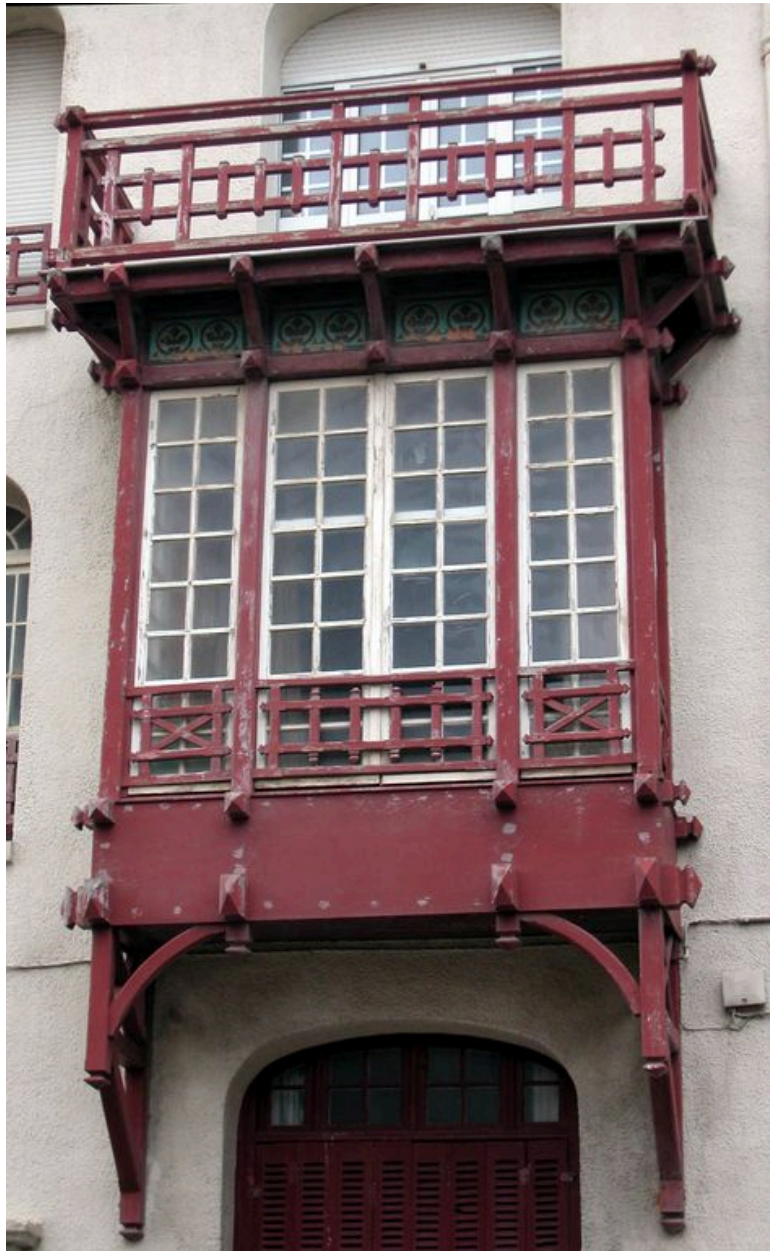
Détail du bow-window surmonté d'un balcon.
