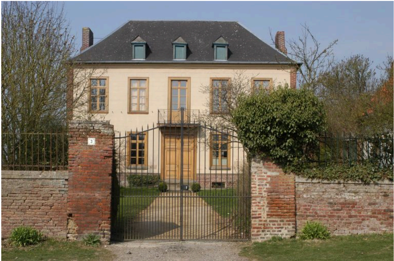
Vue du corps de logis depuis la rue à l'est.
