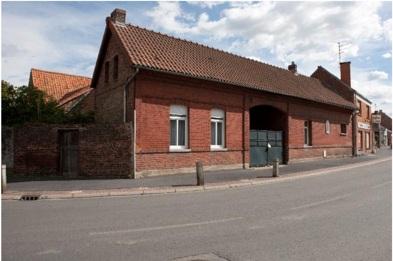
Vue générale de trois quarts d'une ferme à cour fermée 778 rue Suzanne-Lanoy.
