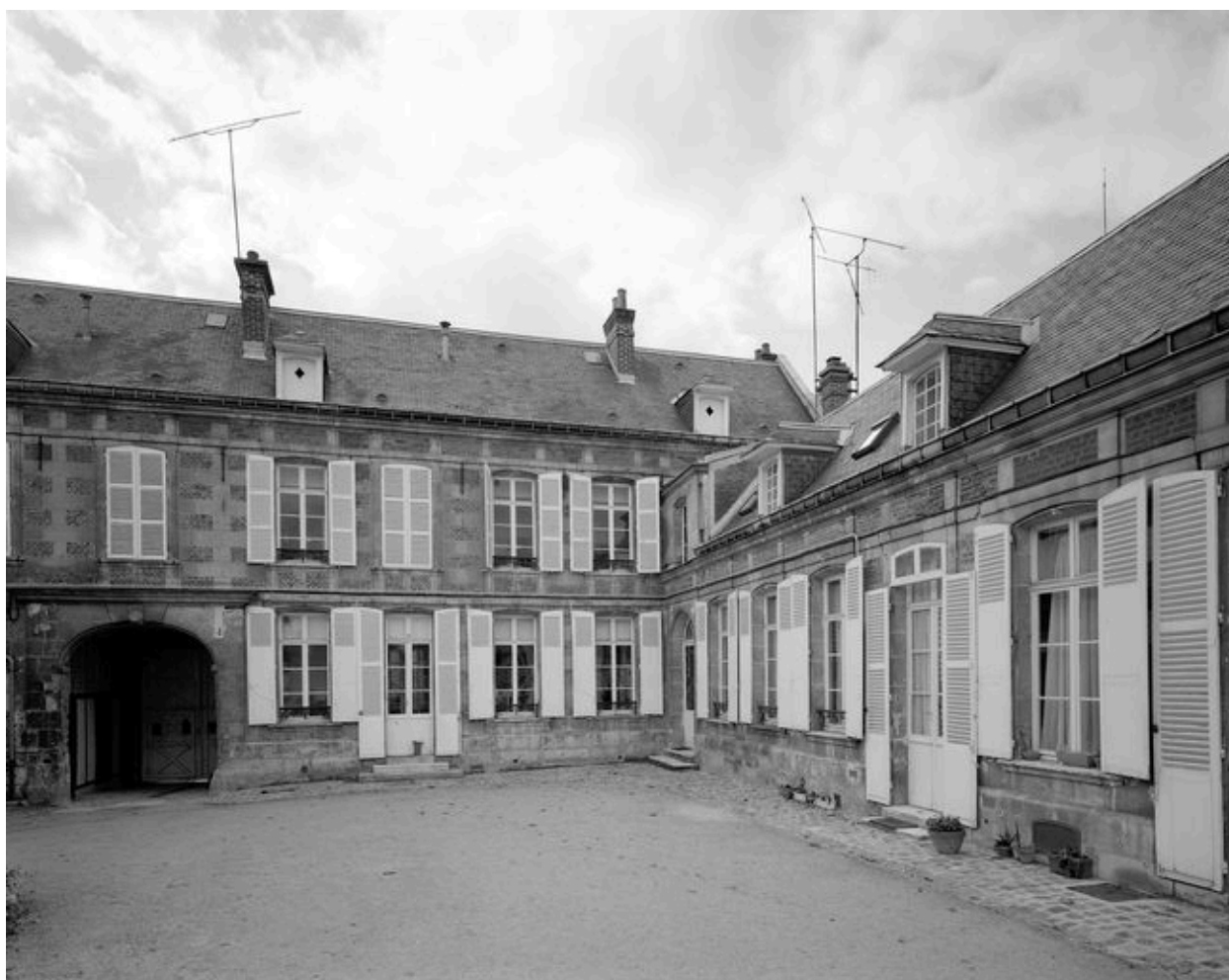
Elévation sur cour.
