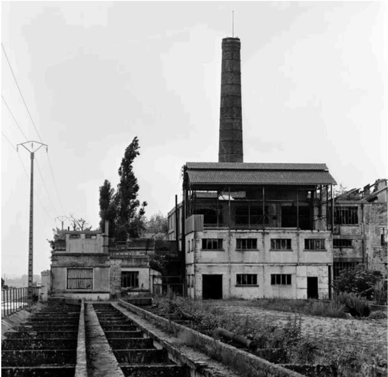
Ateliers de fabrication flanc sud et aire de lavage (transporteur hydraulique).
