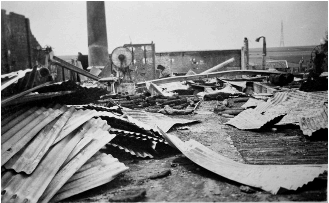
Etat des destructions après l'incendie de 1942 (AP).
