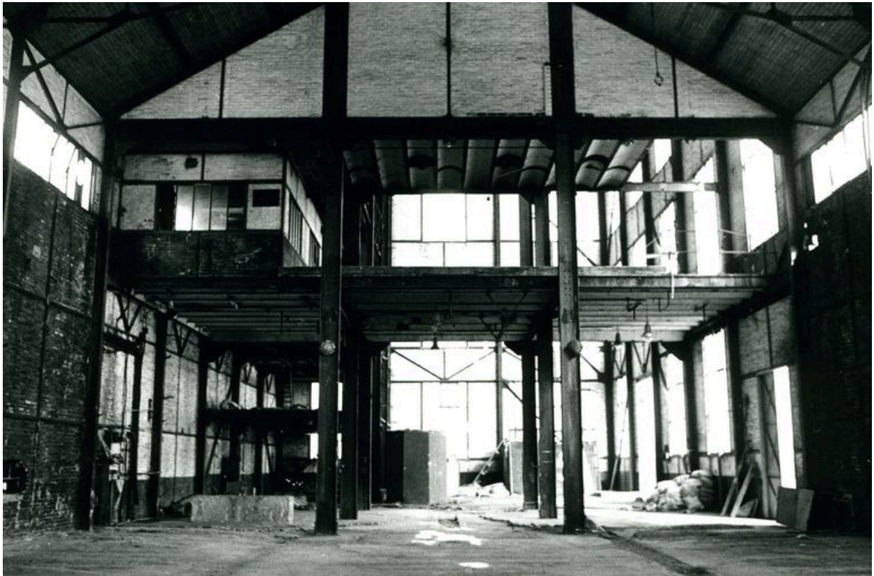
Atelier, vue intérieure.
