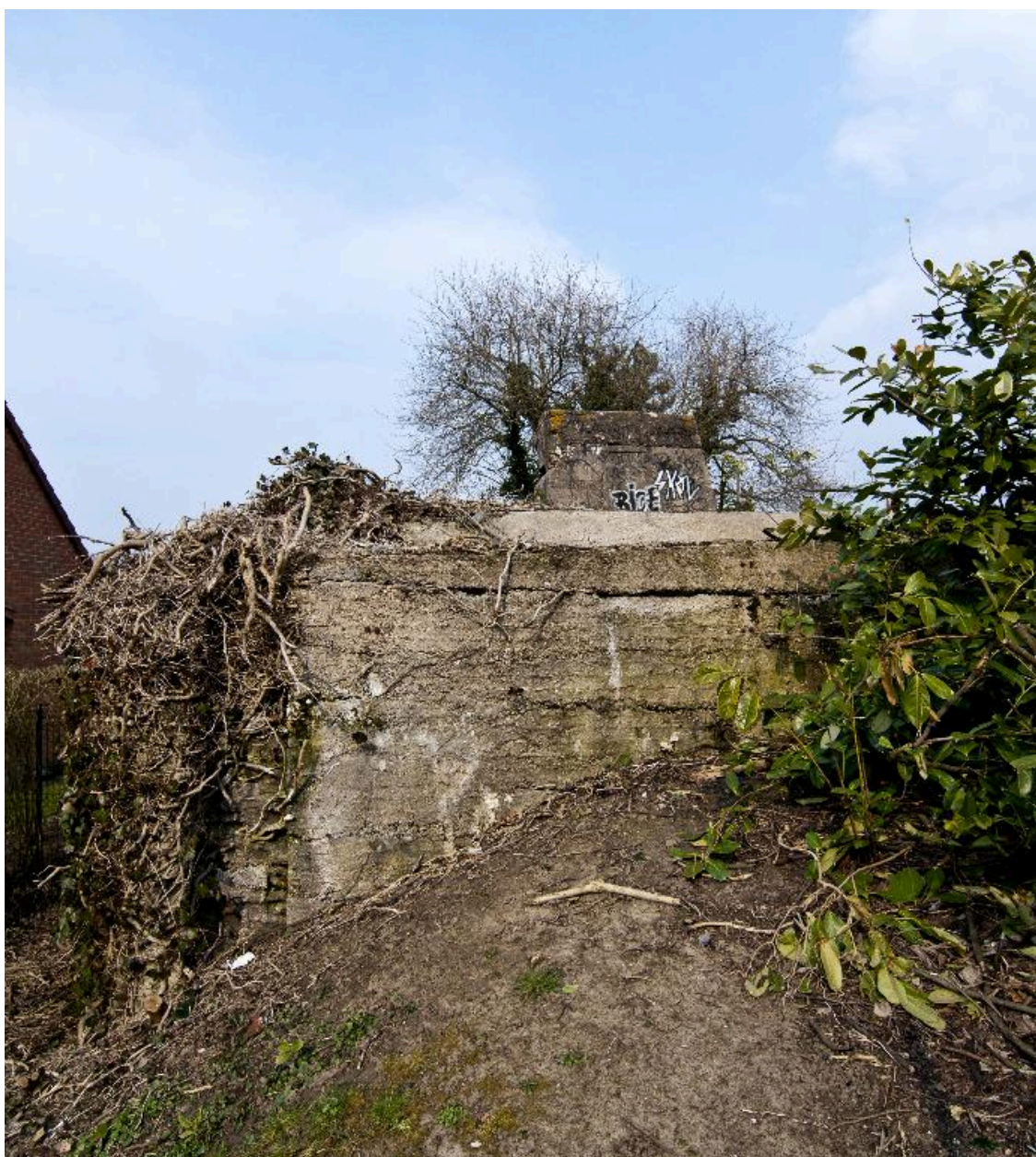
Vue vers le nord (au grand angulaire)
