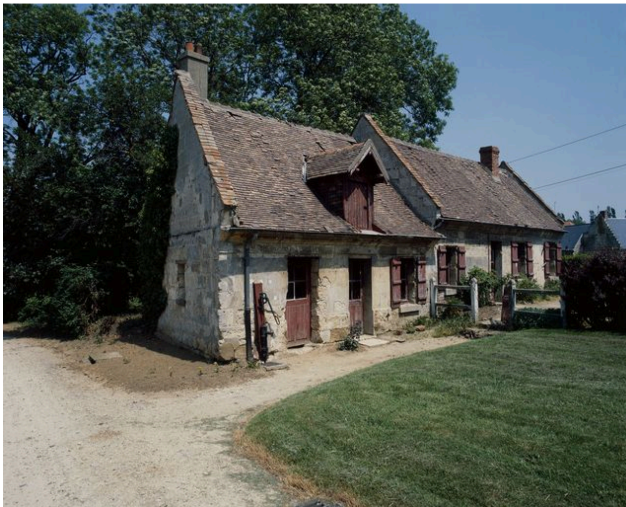
Logements de domestiques.
