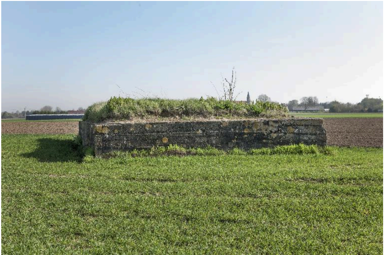
Vue générale vers le nord-est
