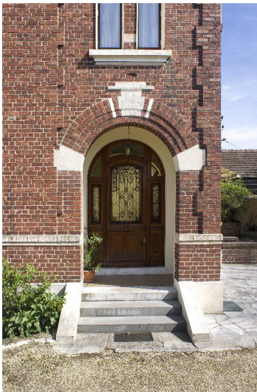
Porte d'entrée principale, vue générale.
