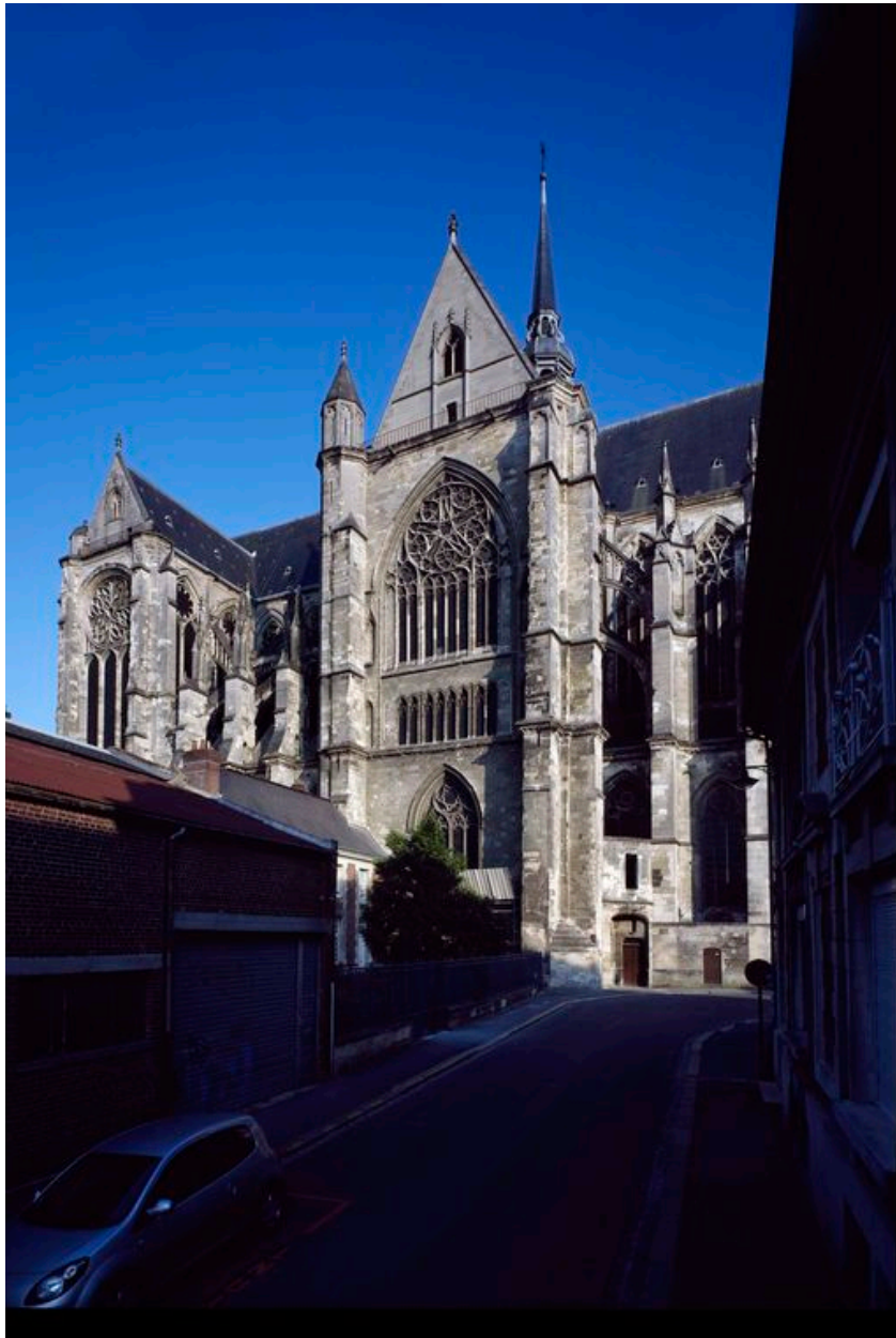
Vue de l'élévation nord du chœur.
