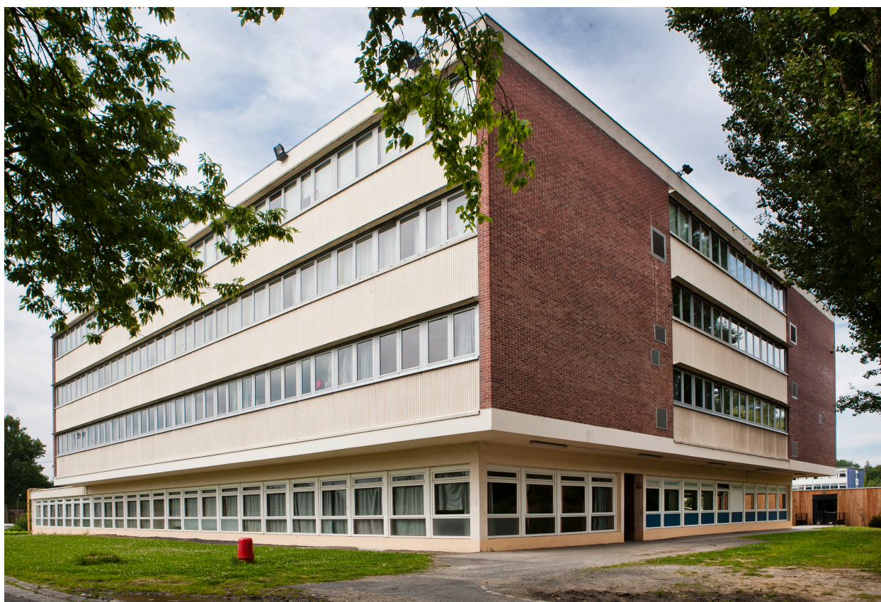
internat de filles (lycée) : façades ouest et sud, 2016.
