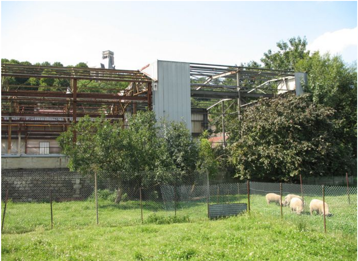
Détail des derniers bardages des ateliers.
