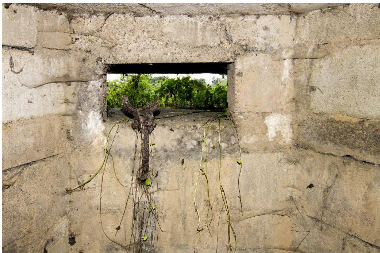
Tourelle sud. Embrasure de tir avec support de mitrailleuse
