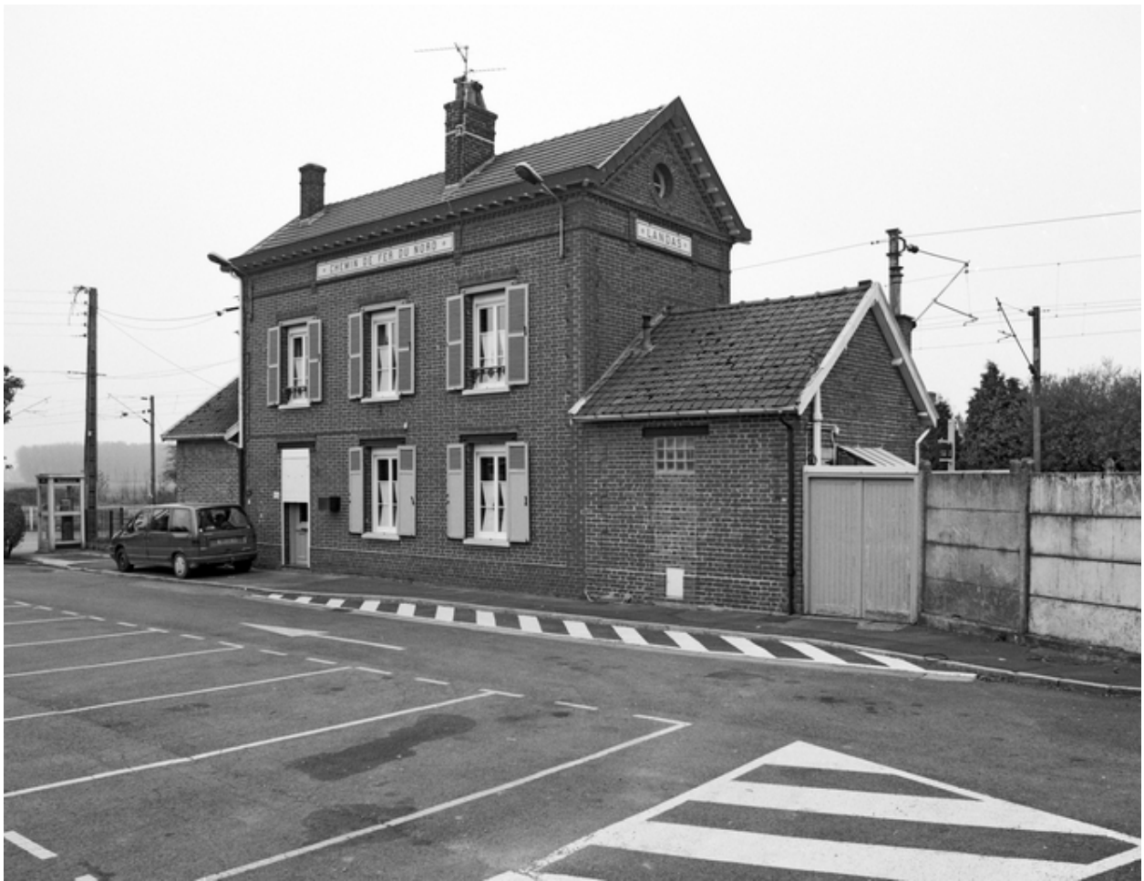
Gare de Landas, façade sur la place, rue du Maréchal-Leclerc (19e).
