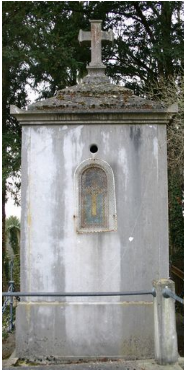
Vue rapprochée de la façade postérieure.
