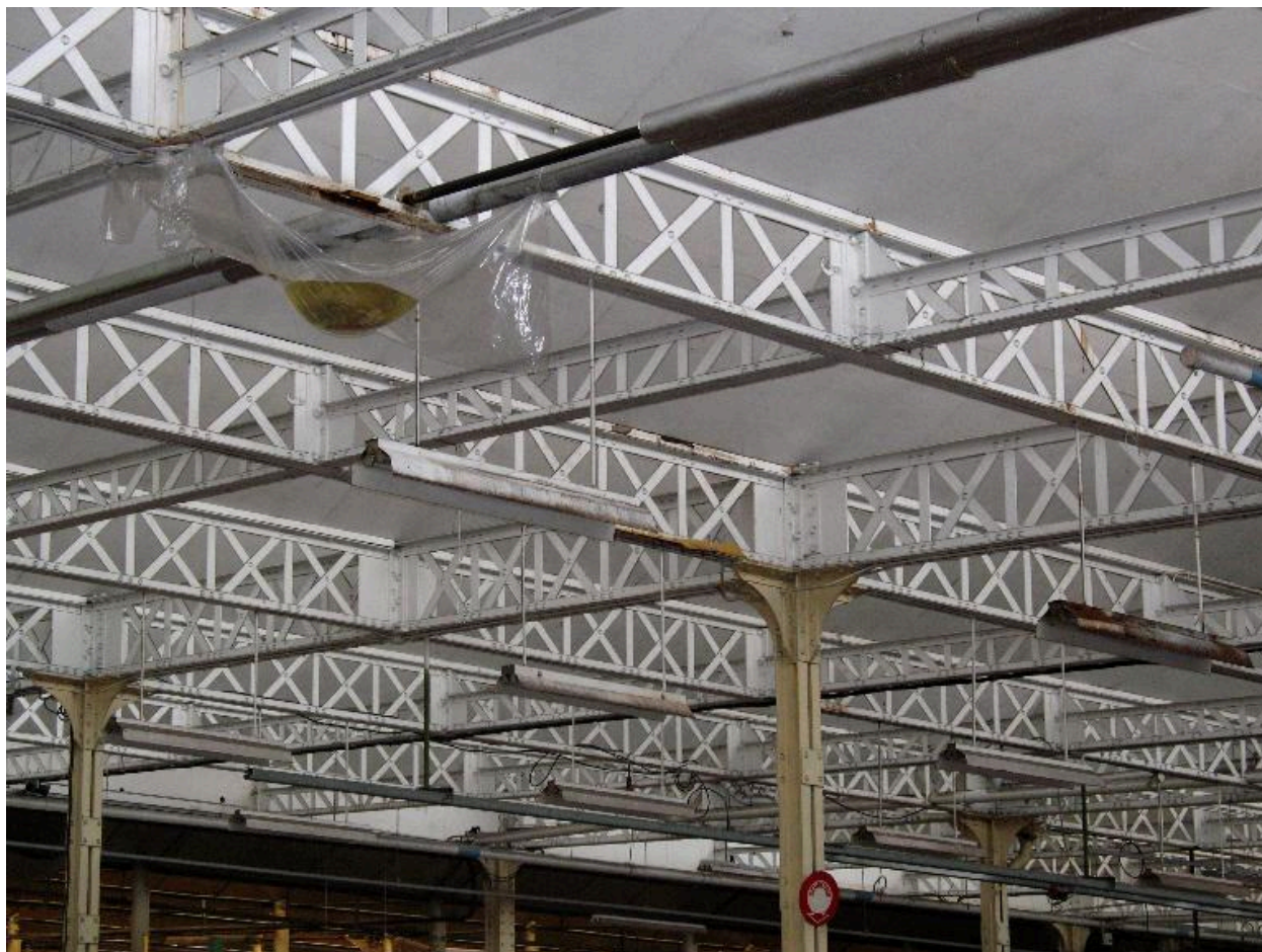
Détail de la charpente métallique étrésoillonnée du tissage de jute.
