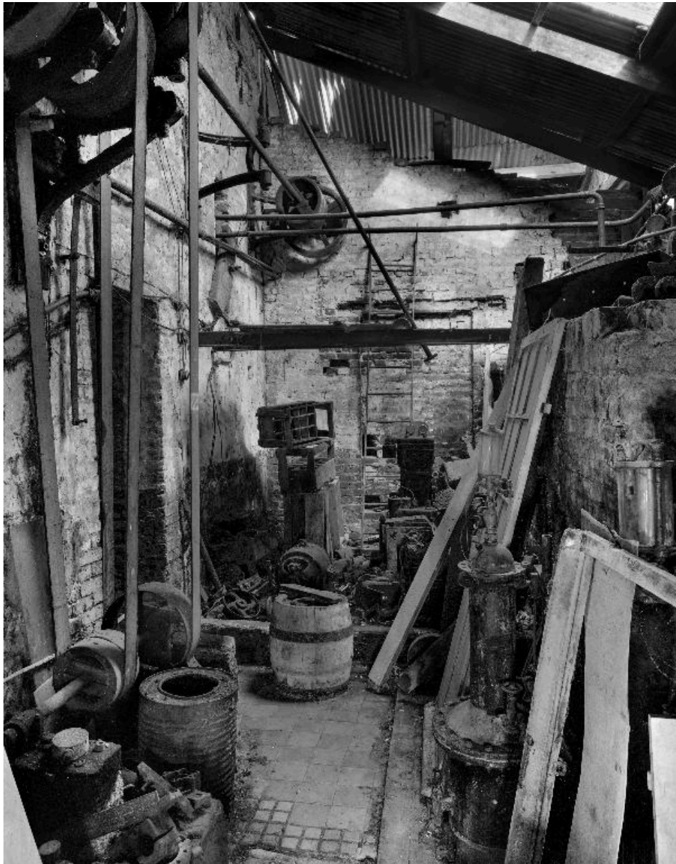
Vue partielle de l'atelier de fabrication.
