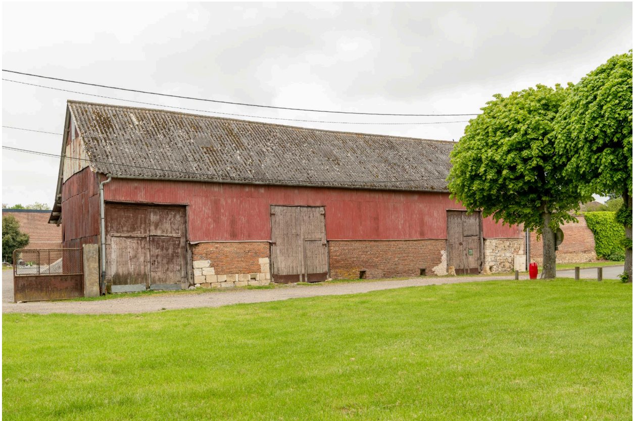
Grange, n°1 rue de la Voierie, vue prise depuis l'est.
