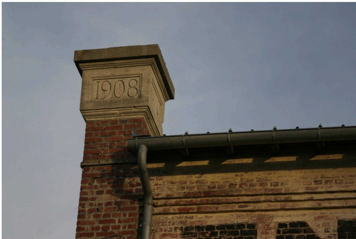
Détail d'un acrotère portant la date 1908.
