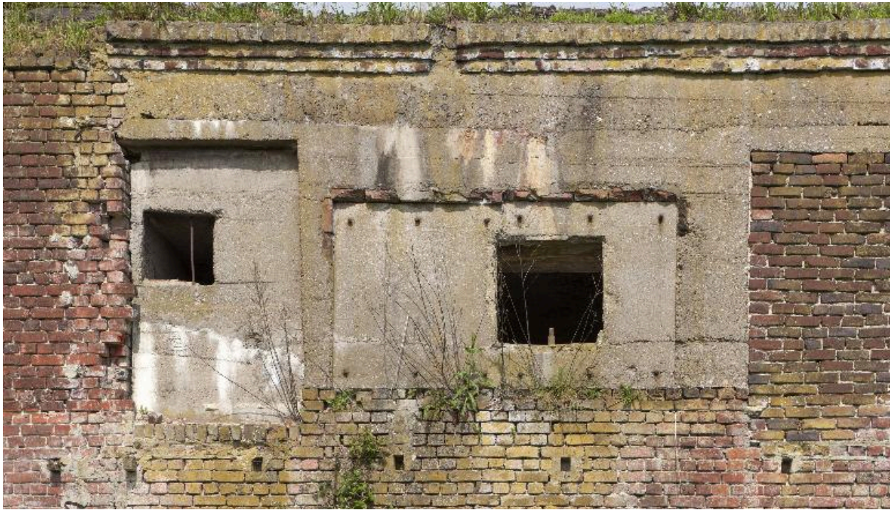
Elévation postérieure, détail des ouvertures de tir
