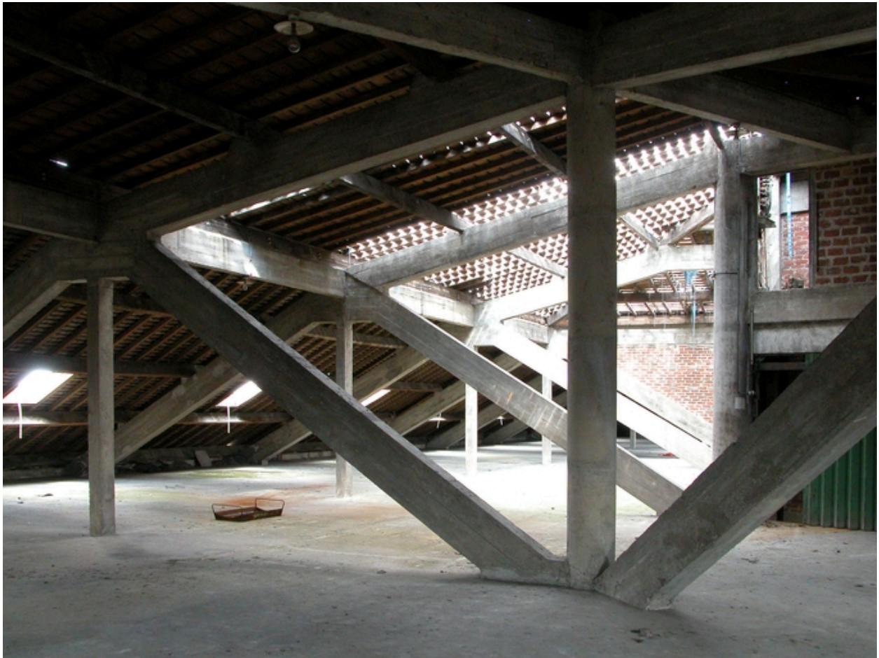
Ateliers des années 1946-48 : charpente en béton armé.
