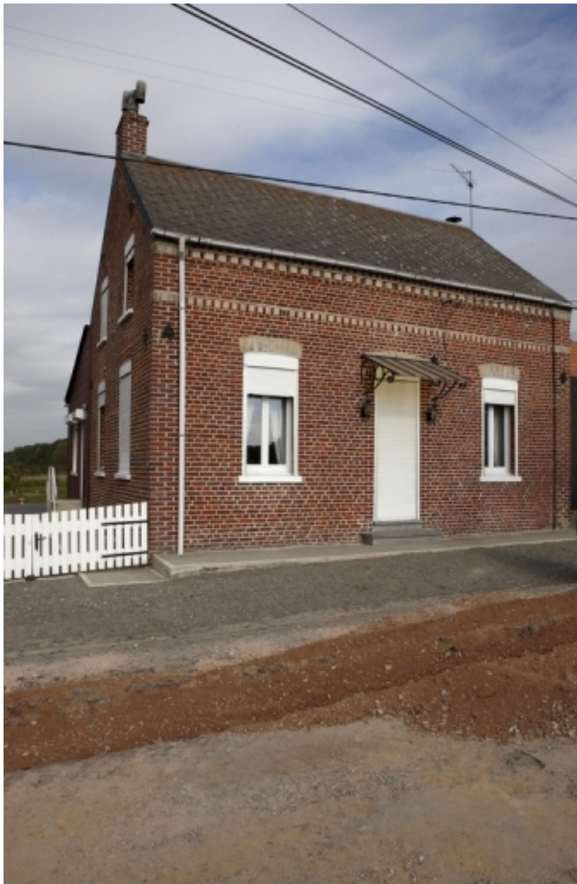
Vue générale de la maison située 1424 rue du Sarlonton.
