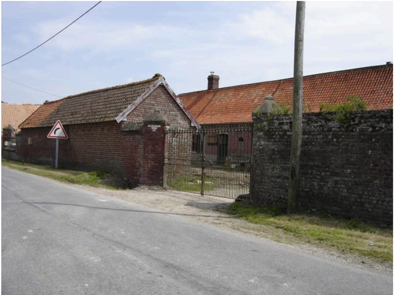
Vue sur les étables à l'ouest le long de la rue.
