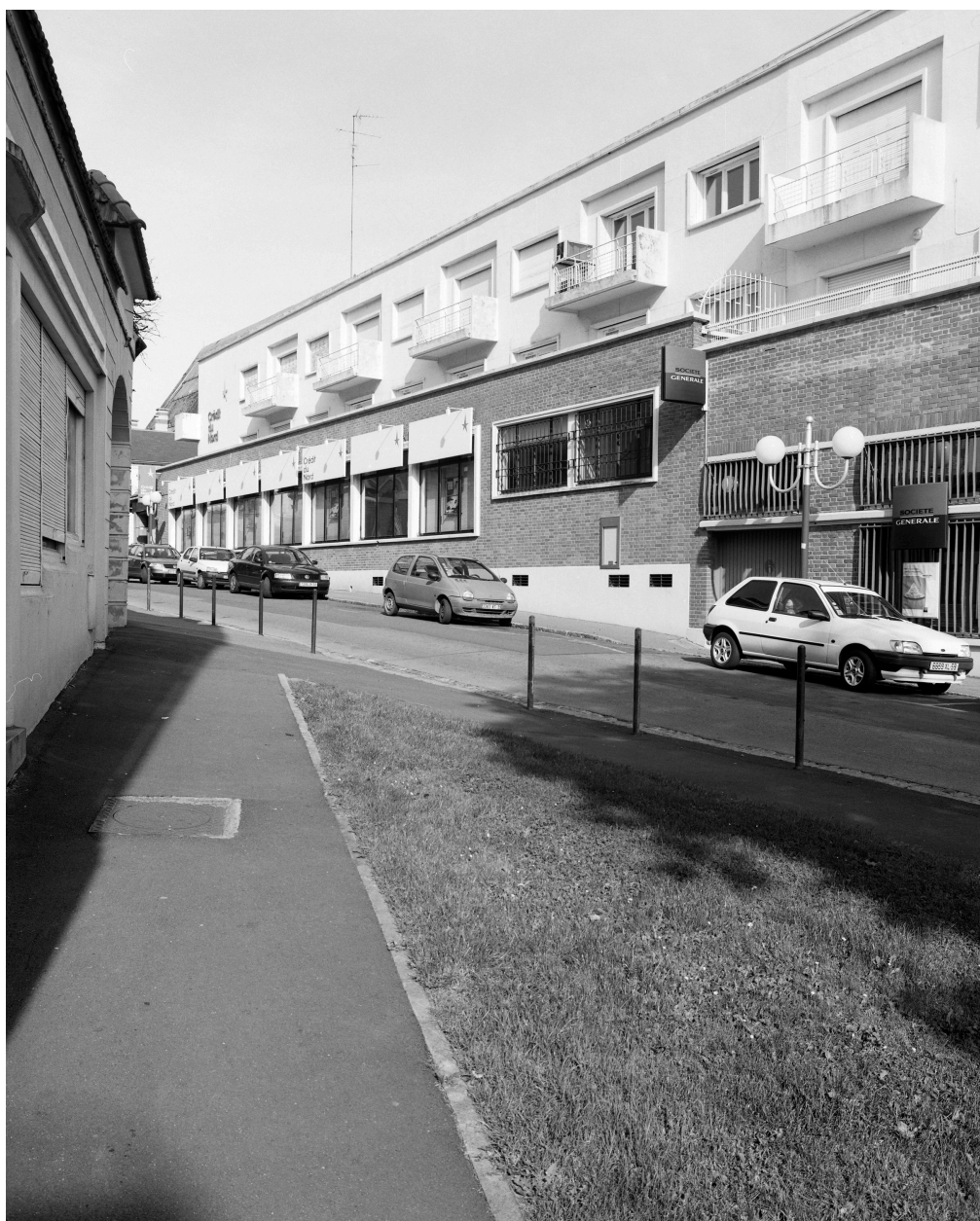
Élévation antérieure de la banque Crédit du Nord, rue Lazare Carnot.
