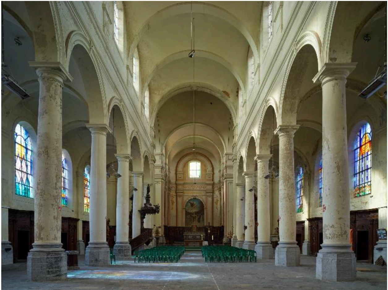
Vue générale intérieure vers le chœur.
