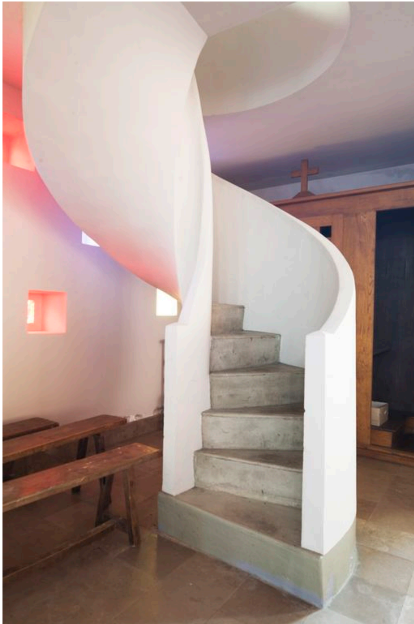
Escalier conduisant à la tribune.
