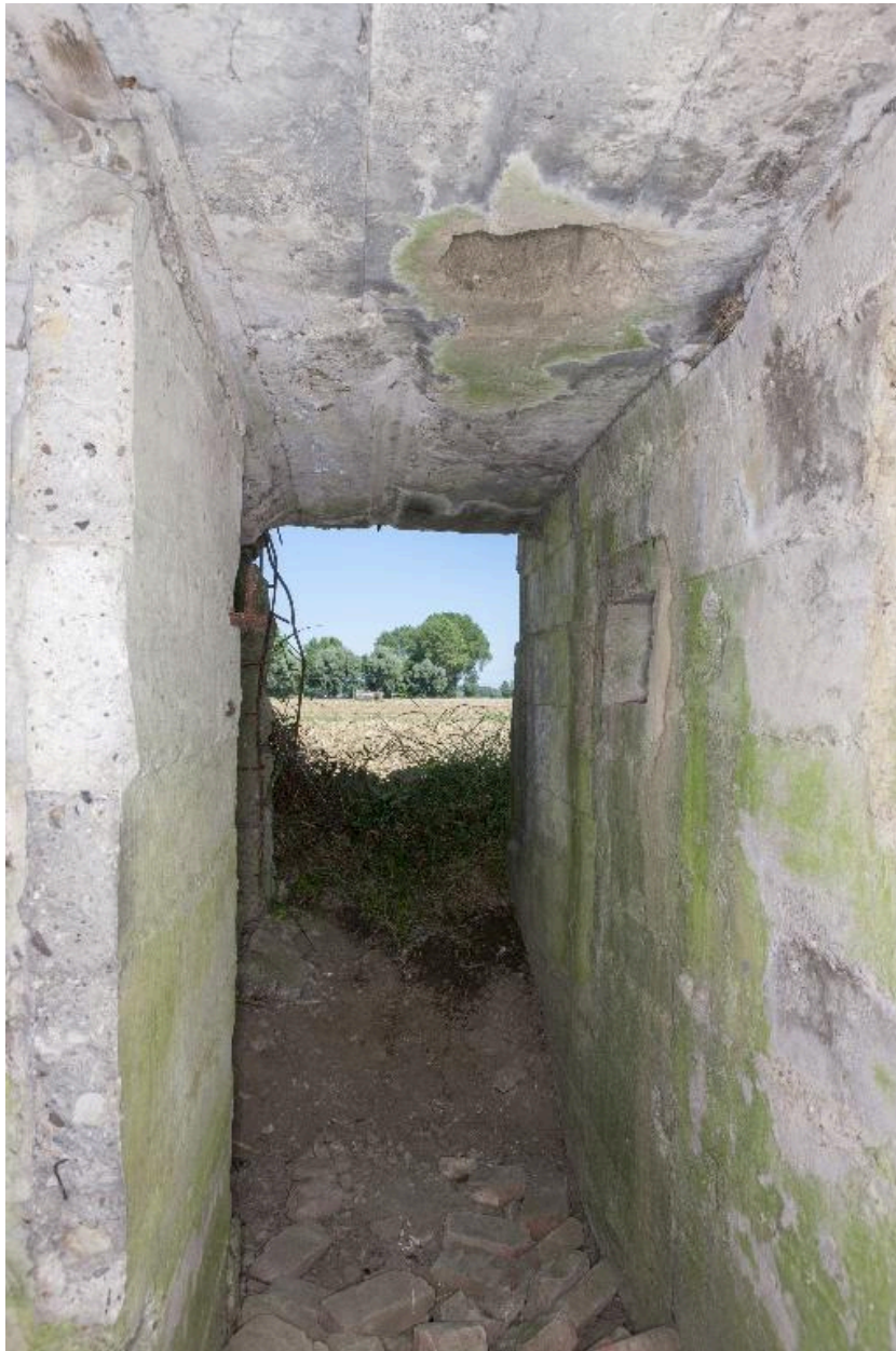
Intérieur du couloir de distribution, vers nord-ouest
