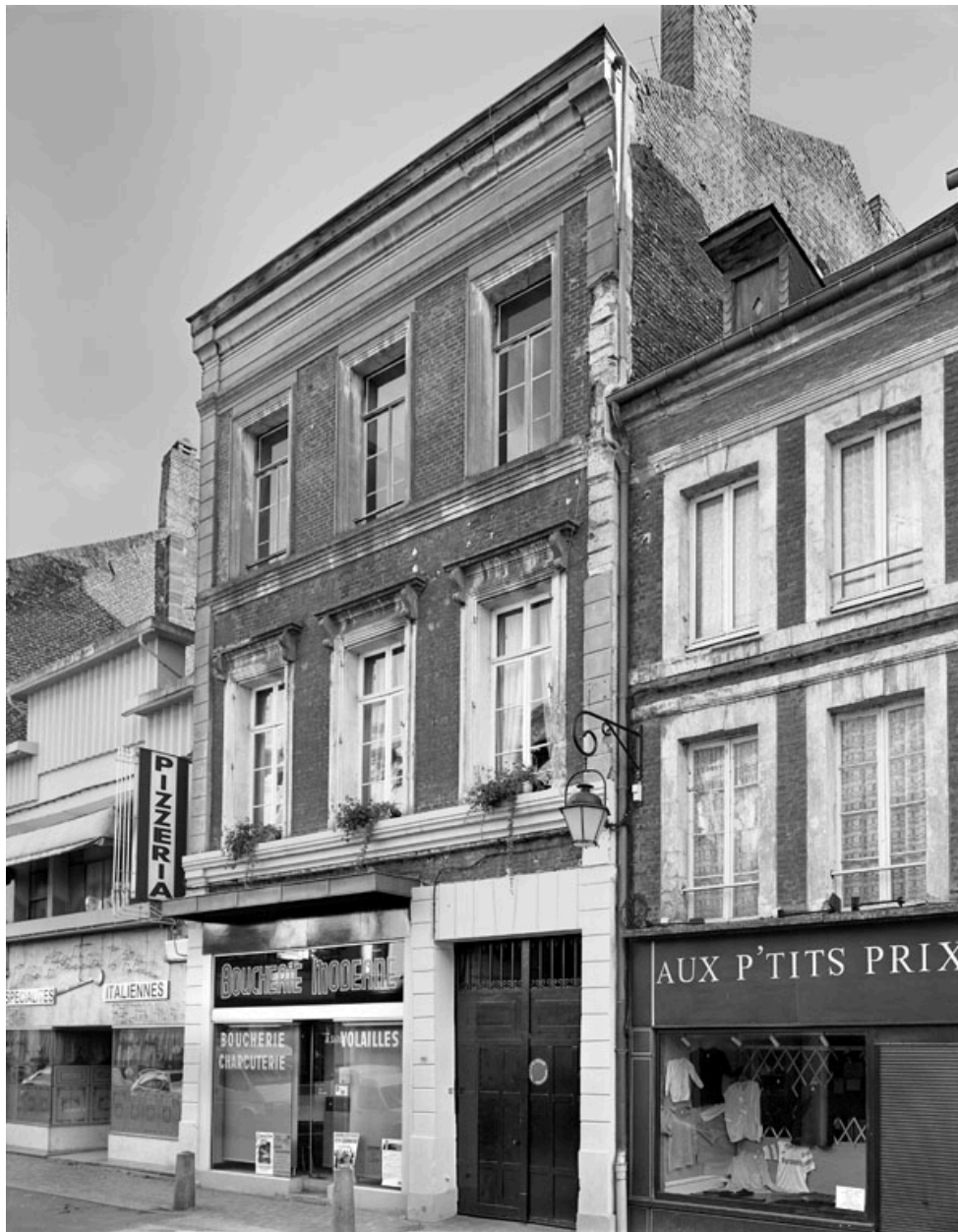
Vue de la façade sur rue.
