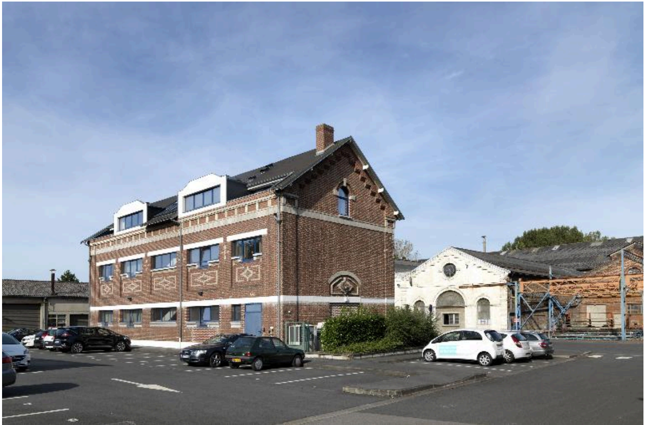
Bâtiment administratif, façade postérieure vue de trois-quarts.
