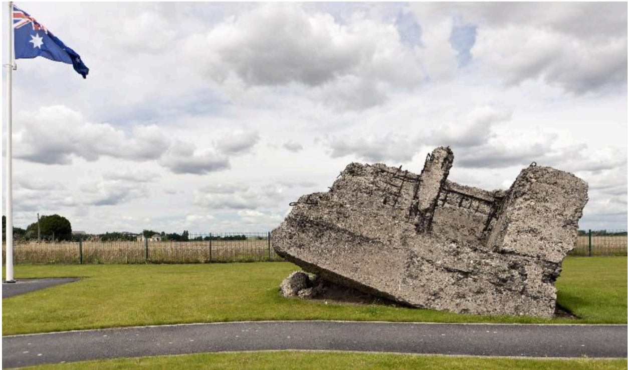
Vestiges de la casemate (e) retournée lors de l'explosion d'une mine, vers le nord
