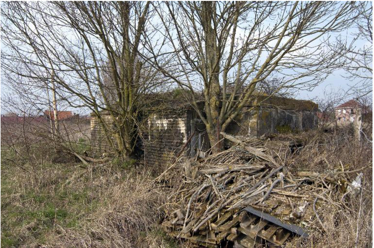
Vue de trois-quarts vers le nord
