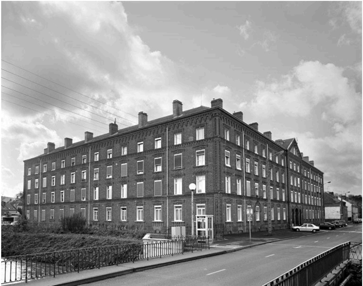
Vue des façades sur rue.
