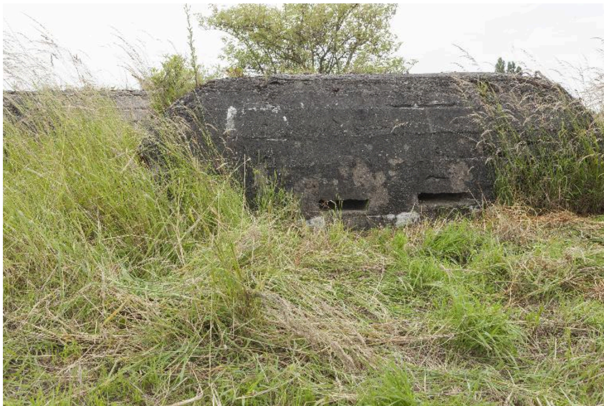
Casemate b. Elévation nord-ouest. Embrasures de surveillance
