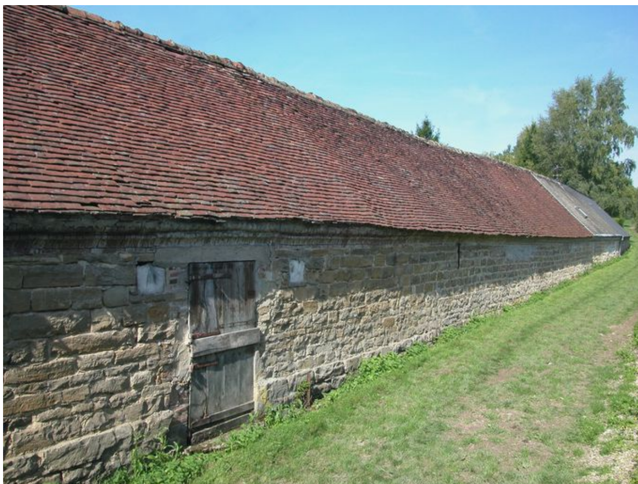
Façade extérieure des dépendances agricoles du moulin.
