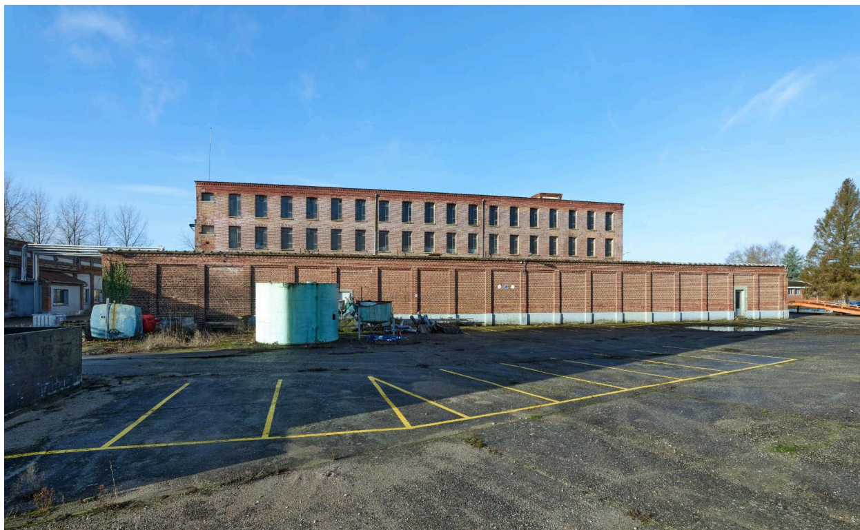
Bâtiment A, vue d'ensemble est.
