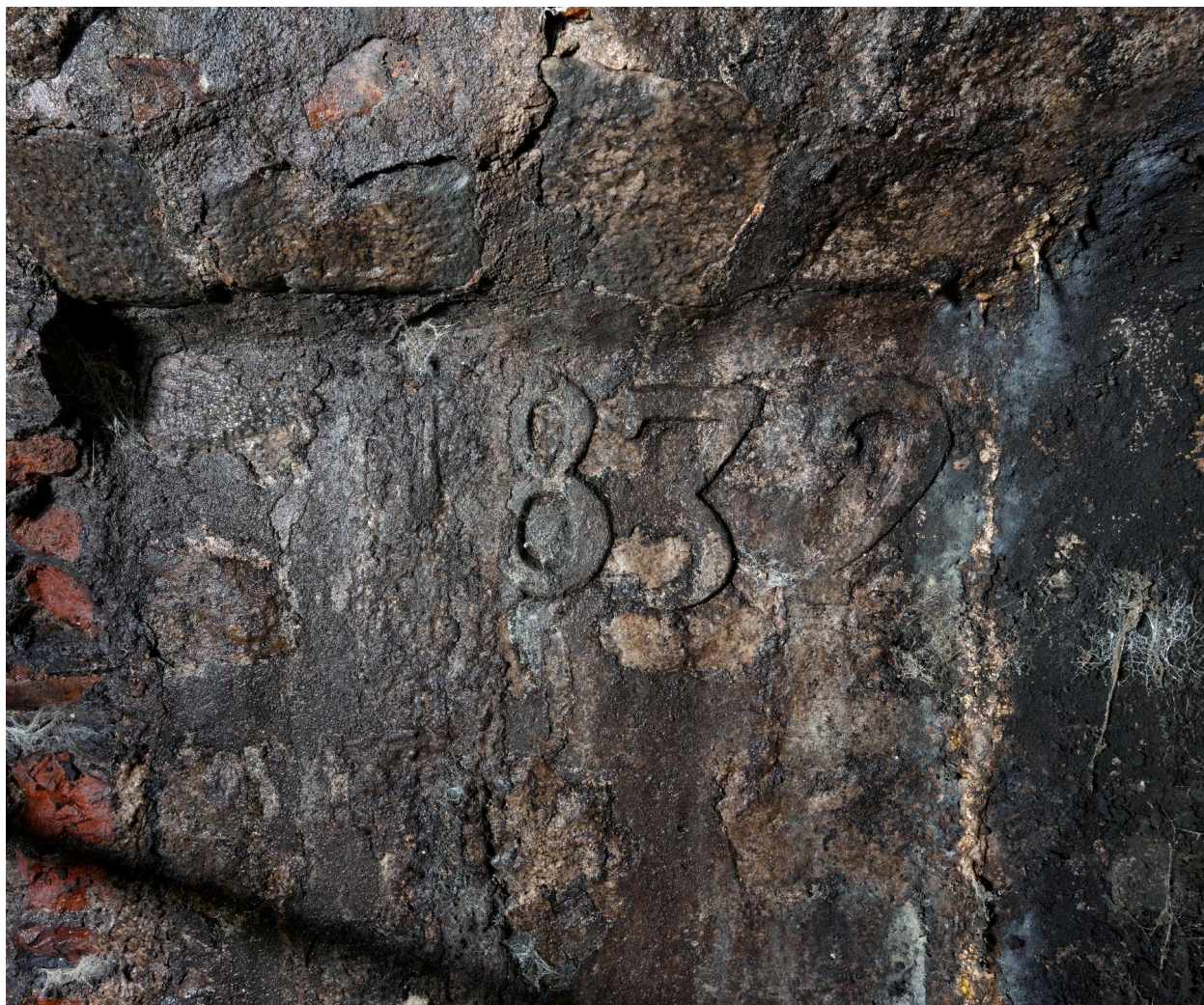
Bâtiment K, détail de la date de 1832 gravée au sous-sol du bâtiment.
