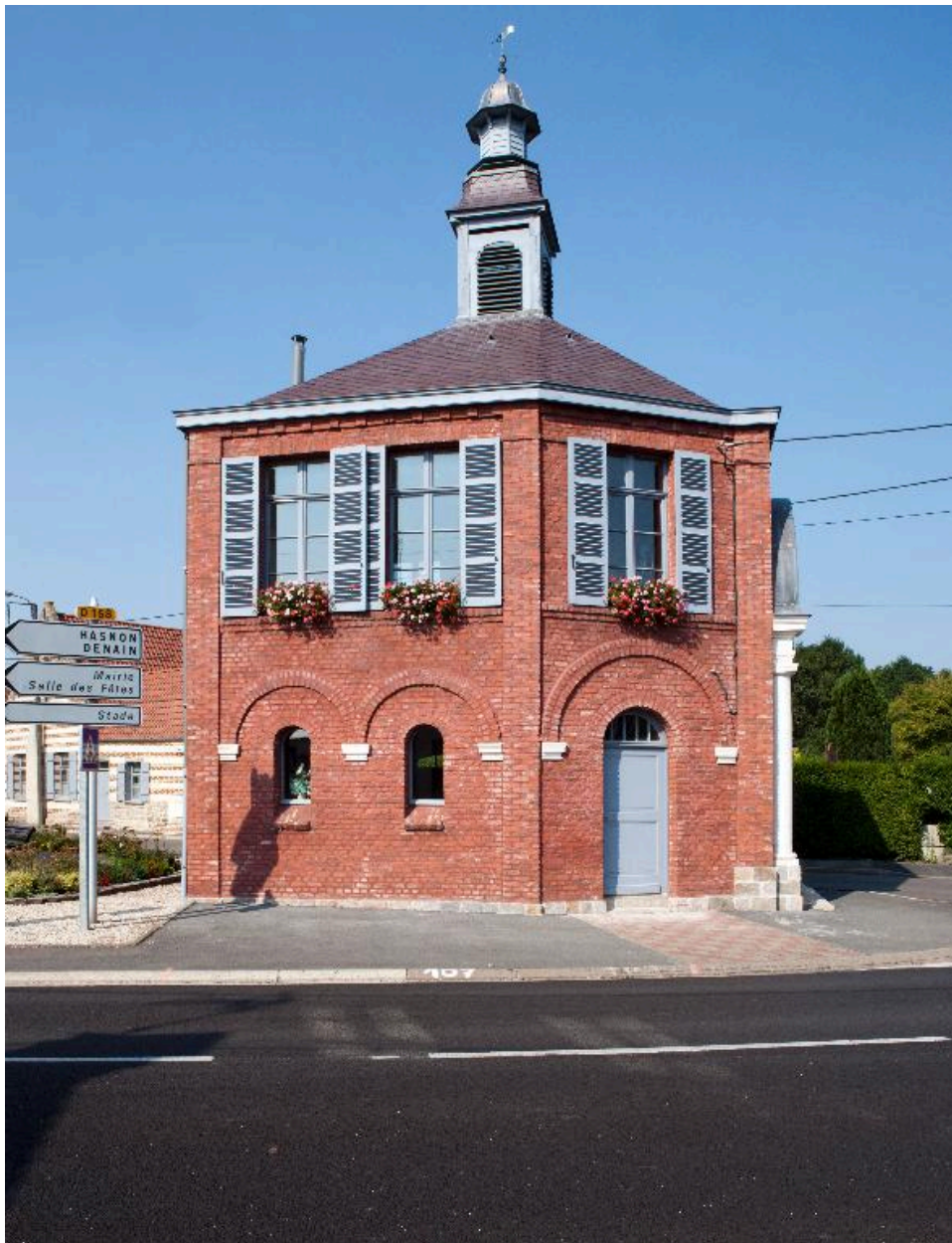
Vue de la façade de la mairie.
