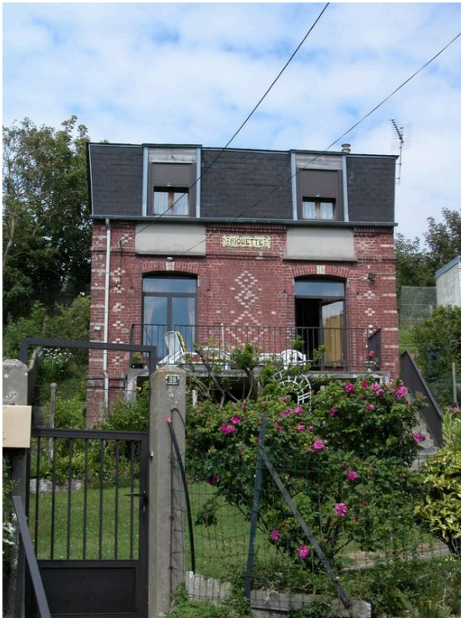
Maison dite Riquette, 39 rue Saint-Pierre (1983 AC 616).
