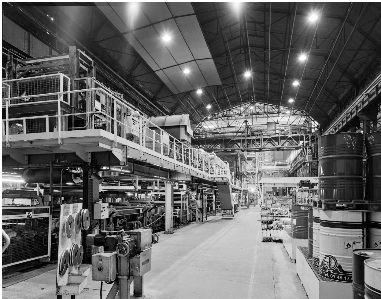
Vue générale de la ligne de galvanisation et de peinture.
