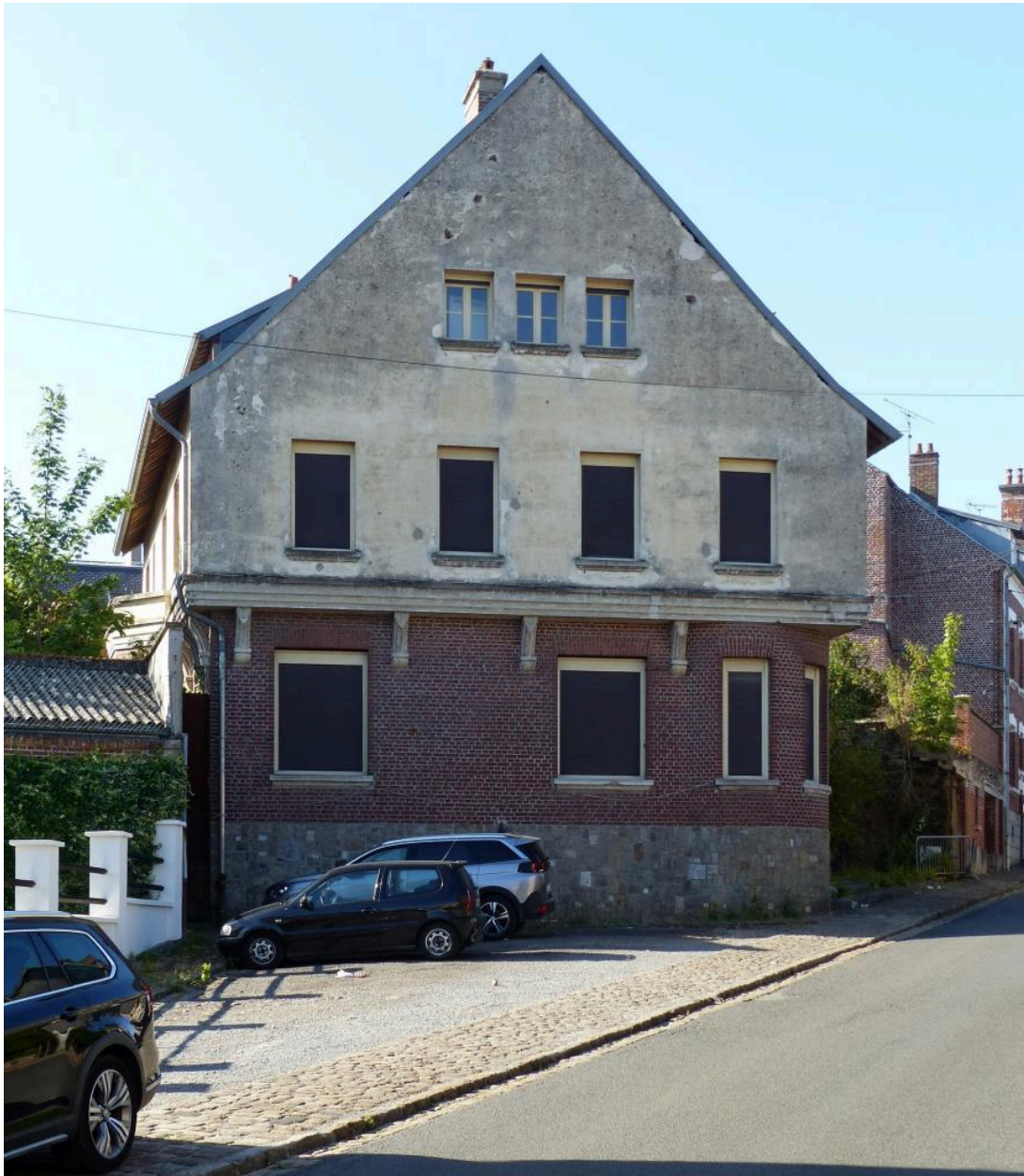
Vue de la façade nord.
