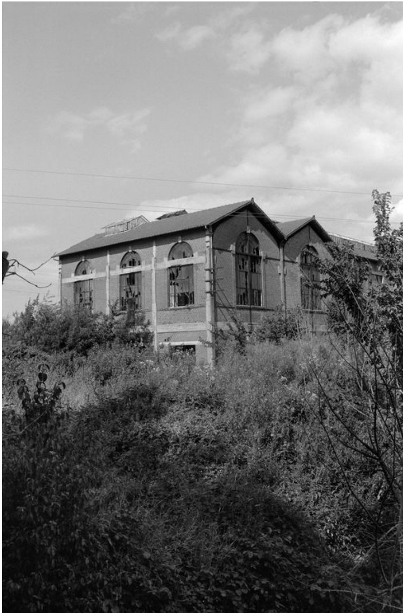
Centrale thermique, en 1988 : flanc ouest.
