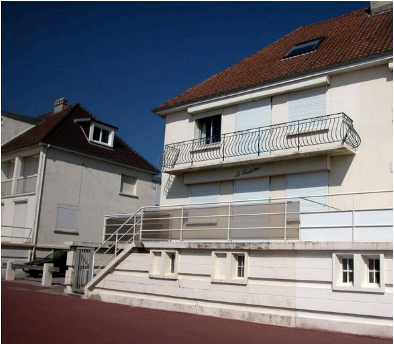
182 boulevard maritime sud (Les Scalaires), façade sur mer.
