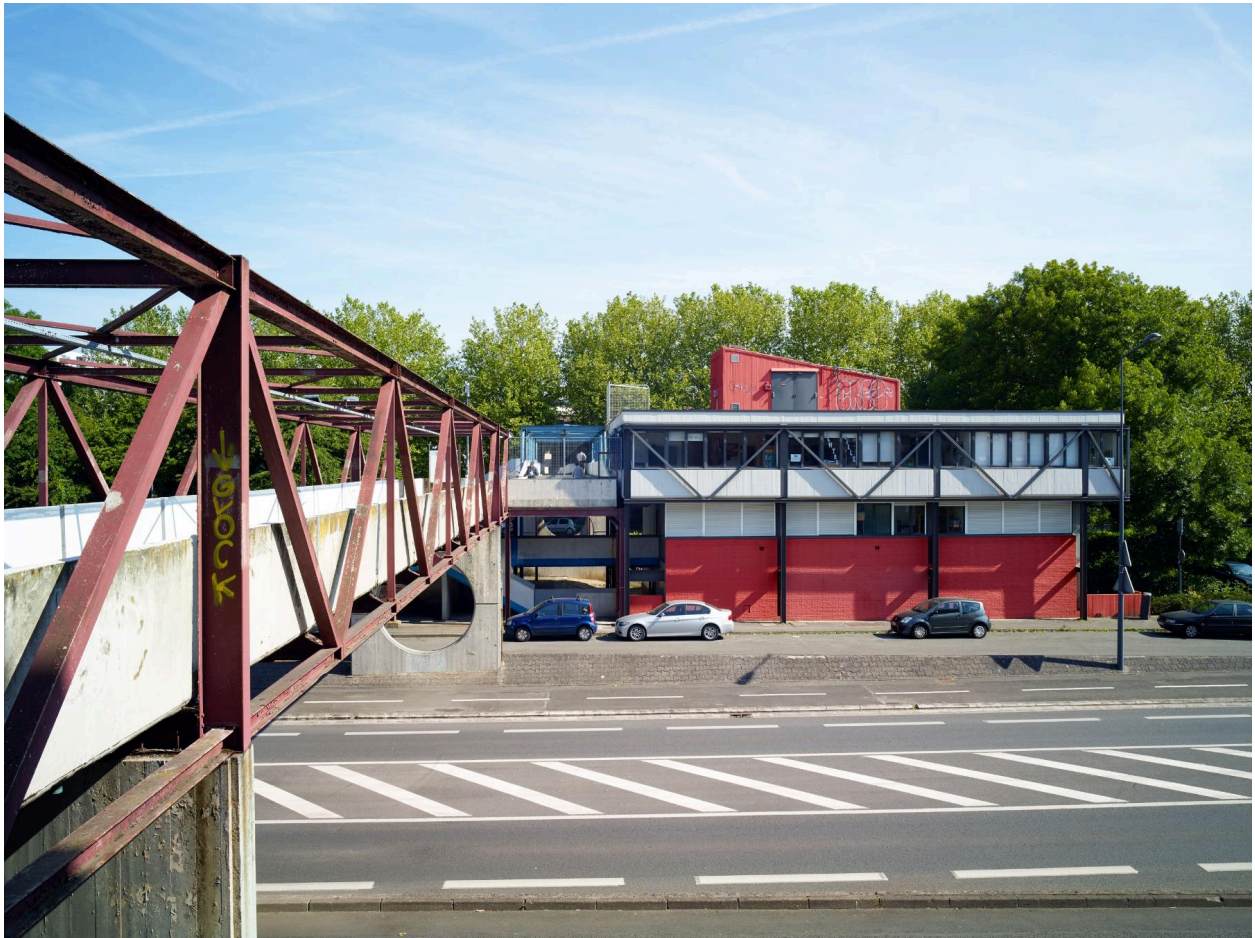
Le centre social (quartier l'Hôtel-de-Ville) peu avant sa destruction.
